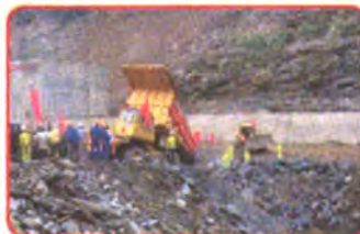
Lắp sông Công thủy điện Bân Vê
