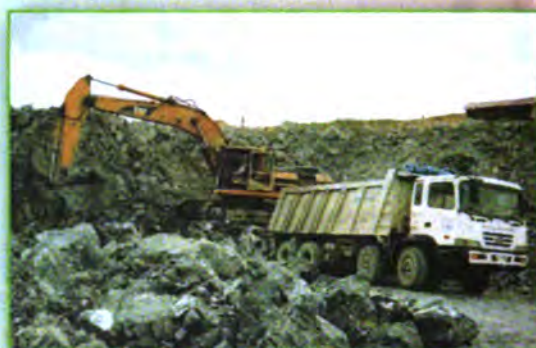
Khai thác mỏ đá Văn Xá cung cấp cho nhà máy xi măng Luksvaxi
