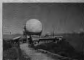
Trạm Radar thông tin Sơn Trà Trung tâm quản lý bay Miền Trung
