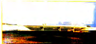
Cầu Bến Gạo qua sông Phô Đáy nối liền Lập Thạch với tỉnh lỵ và các huyện trong tỉnh
