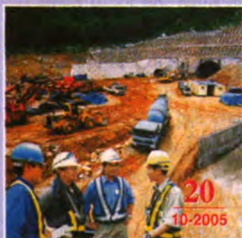
Bìa 1: Thi công đường hầm Hải Vân (của phía Bắc)
