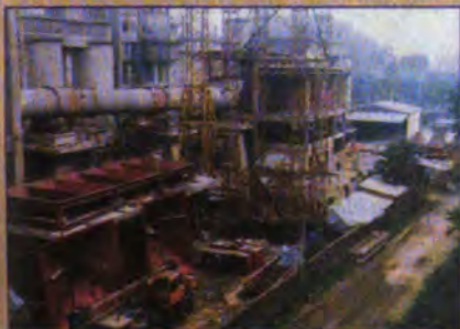
Lắp đặt dây chuyền công nghệ xi-măng lò quay - Công ty CP 77
