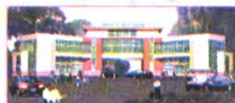
Trạm Kiểm soát liên hợp Chi Ma
