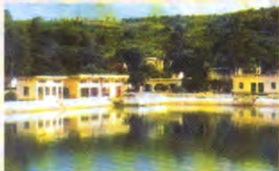
Nhà máy nước Bể Sơn
