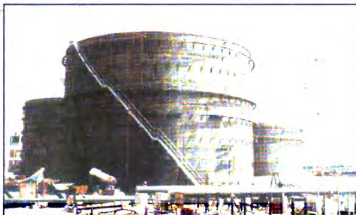
Chế tạo và lắp đặt kết cấu thép, hình bể cho các công trình công nghiệp
