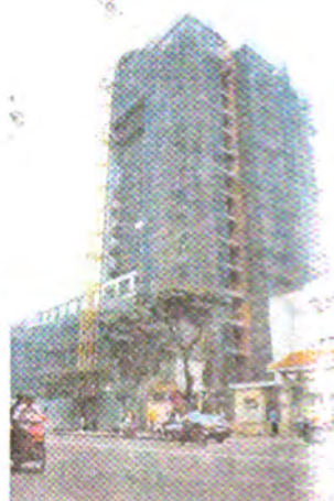
Công trình Đài truyền hình TP.HCM
