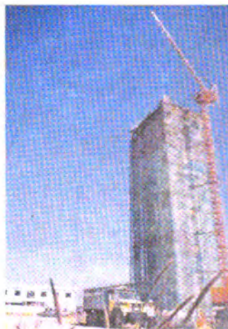
Tháp cất áp - Dự án nước sông Sài Gòn
