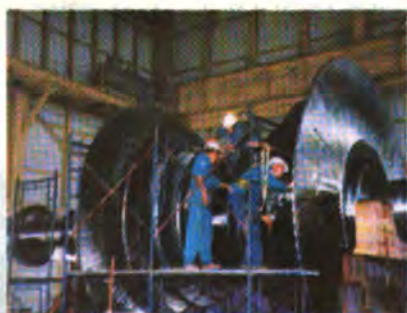
* Lắp đặt tua bin hơi cho NM nhiệt điện
