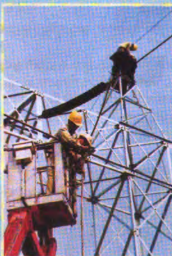
Thi công lắp đặt thiết bị mở rộng trạm 220 KV Sóc Sơn
