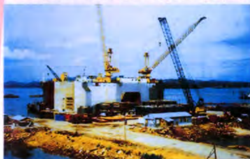
Đúc thùng chìm 1 800 tấn thi công Cảng Cái Lân
