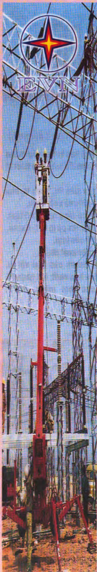
Thi công lắp đặt thiết bị mở rộng trạm 220 KV Sóc Sơn
