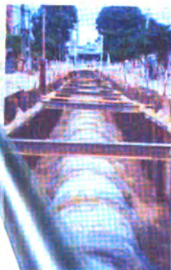
Lắp đặt cống tròn
