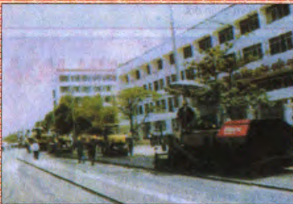
Dây chuyền thi công cơ giới rải thảm bê tông nhựa nóng
