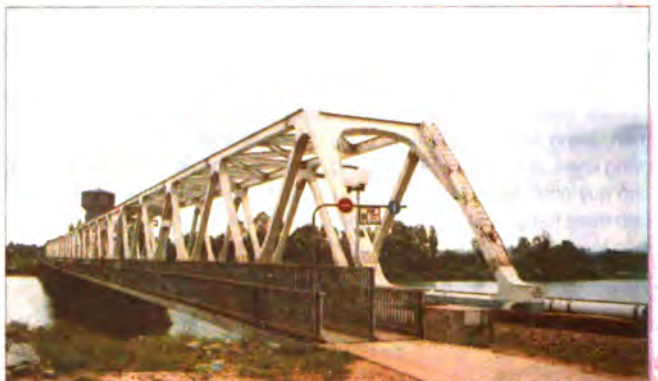
Cầu Bành Hồ - TP Huế thuộc dự án 6 cầu đường sắt Hà Nội - TP Hồ Chí Minh do Công ty thi công
