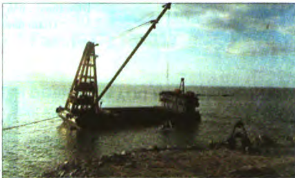
Nạo vét bùn chuẩn bị thi công dê chắn sóng.
