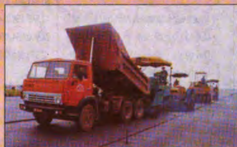
Máy liên hợp trải - đầm bê tông nhựa nóng Vögele super 1800 (AB 475 - TVP 2) CHLB Đức
