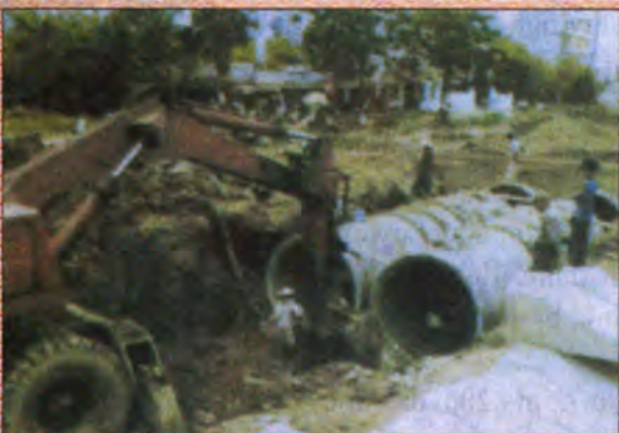
Thi công cống
