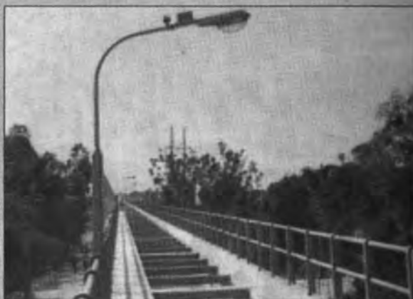
Công trình Cầu máng Củ Chi, TP.HCM - Dài 1.060m. Mang Bridge, Cu Chi, HCMC - Length 1.060m.
