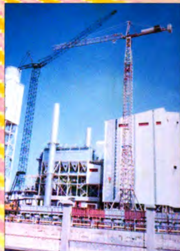
Thiết bị cầu - chuyển thi công Nhà máy Xi măng Sao Mai - Hà Tiên
