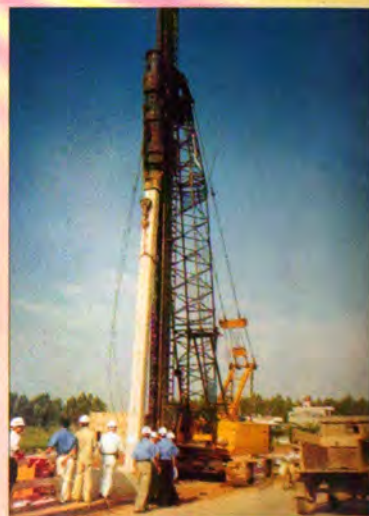
Đóng cọc, xử lý nền móng cầu quốc lộ 18 Bắc Ninh
