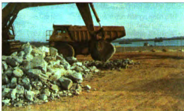
Chuẩn bị đá cho thi công dê chắn sóng
