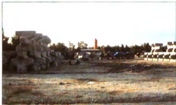
Sản xuất acsopode thi công dê chắn sóng.
