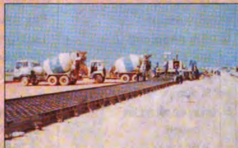
Thi công đường cốt pha cát 25 - L Sân bay Tân Sơn Nhất bằng máy trải bê tông ván khuôn trượt SP-500 (CHLB Đức)
