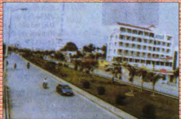
Phố Nguyễn Chí Thanh do công ty thi công
