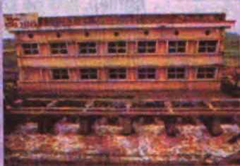
Trạm bơm tiêu Hồng Phong công suất 24.000m 3 /h
