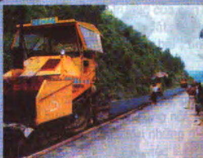
Thi công đường Hồ Chí Minh
