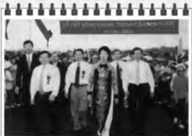
Khởi công xây dựng cầu Non Nước
