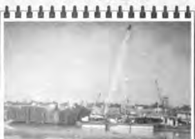
Hệ nổi thi công cầu
