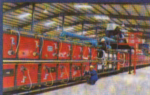
LẮP ĐẶT THIẾT BỊ LỘ SỬNG NHÀ MÁY GẠCH GRANITE ĐỒNG NAI
