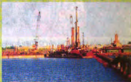
Hệ thống khoan cọc nhồi tại Cầu Tân Đệ
