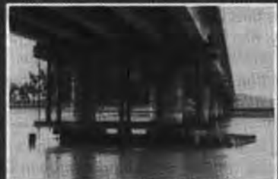
Công nghệ kích năng dầm thay gối cầu bằng ống chịu lực trong điều kiện vận tải giao thông bình thường
