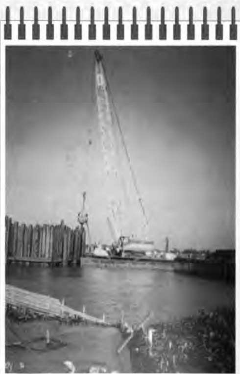
Hạ cọc ván thép bằng búa rung
