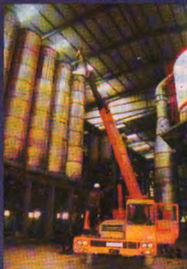
CHẾ TẠO VÀ LẮP ĐẶT HỆ THỐNG SILO BỘT - NHÀ MÁY GẠCH GRANITE ĐỒNG NAI
