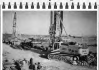
Máy khoan Bg25 \phi 1 000 mm của CHLB Đức
