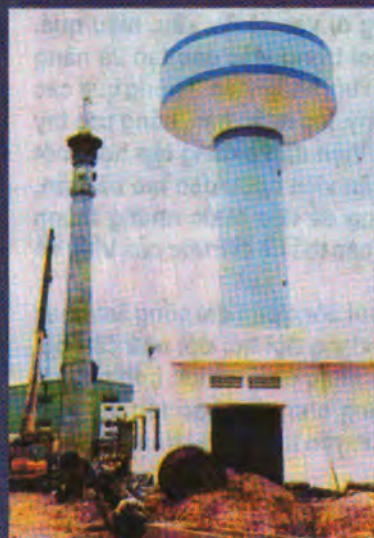
BĂNG CÔNG NGHỆ CỐT - PHA TRƯỢT CÔNG TY XÂY DỰNG SỐ 16 THI CÔNG ống KHỐI 800 và DÂY NƯỚC 4000 2 - NHÀ MÁY KINH NƠI BÌNH DƯƠNG
