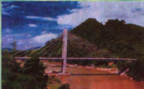
CẦU ĐÀK RỒNG - CÔNG TRÌNH CHẤT LƯỢNG CAO VỀ THIẾT KẾ NĂM 2000
