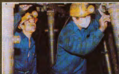
Đưa cột chống thủy lực vào khai thác lò chợ
