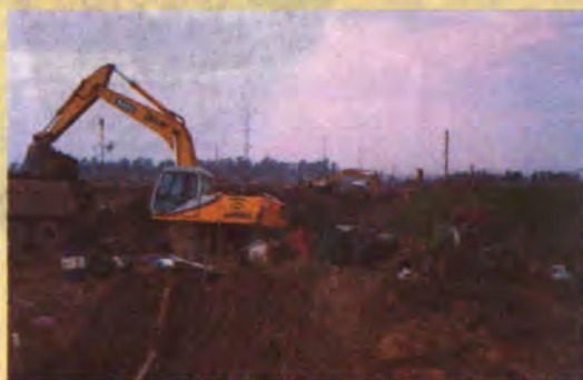
Thi công công trình đường vành đai 3 - Hà Nội
