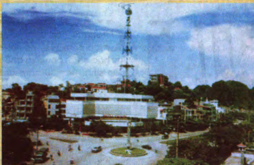
Nhà trung tâm Bưu điện tỉnh Quảng Ninh
