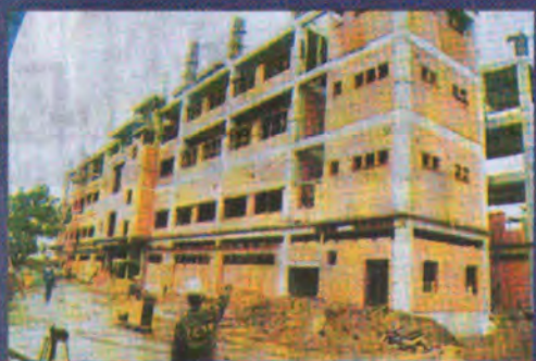
XÂY DỰNG TOWER NHÀ VĂN PHÒNG VỚI TANG HẦM SÂU 5 M CỦA CÔNG TY DỊCH VỤ HÀNG KHÔNG (TÂN SƠN NHẤT)
