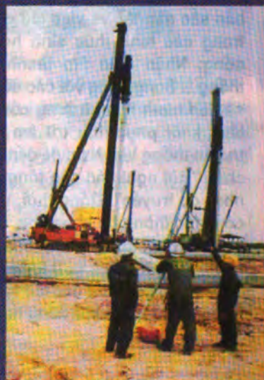
THIẾT BỊ CHUYÊN DỤNG VỚI ĐẦU BUA 6 TẤN THI CÔNG TẠI CÔNG TRÌNH CONDENSATE NAM CỎN SƠN
