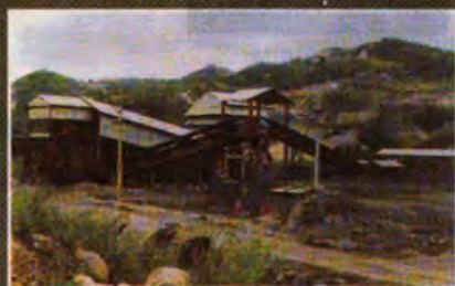
Công trình Cùm Sàng mật bằng + 38 có công suất 500 000 tấn/năm
