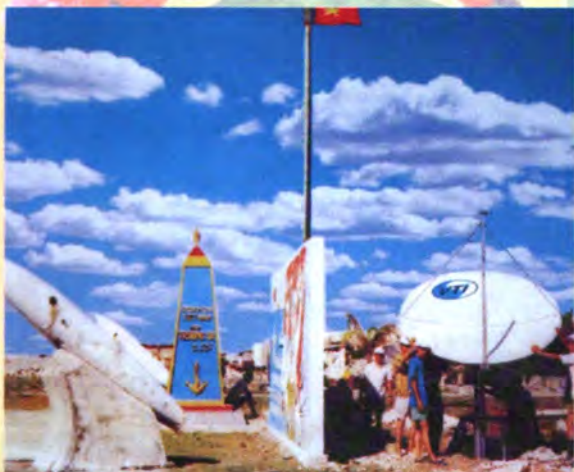
Cán bộ kỹ thuật Công ty VTI lắp đặt VSAT phục vụ các chiến sỹ Trường Sa
