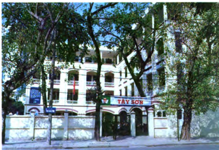
Công trình Công ty thi công
