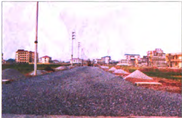
Thi công trình đường Hai Bà Trưng
