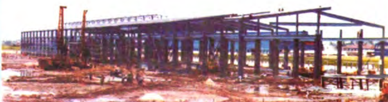
Thi công công trình nhà máy cán thép Hòa Phát, Hải Phòng
