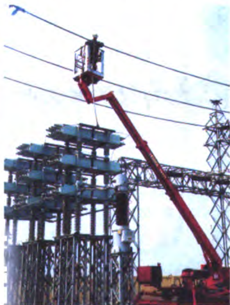
Lắp đặt tụ Bù 110 KW hạng 220 KV Hưng Đông - Vinh
