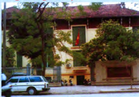
Trụ sở của Viện (59 Lý Thường Kiệt)
