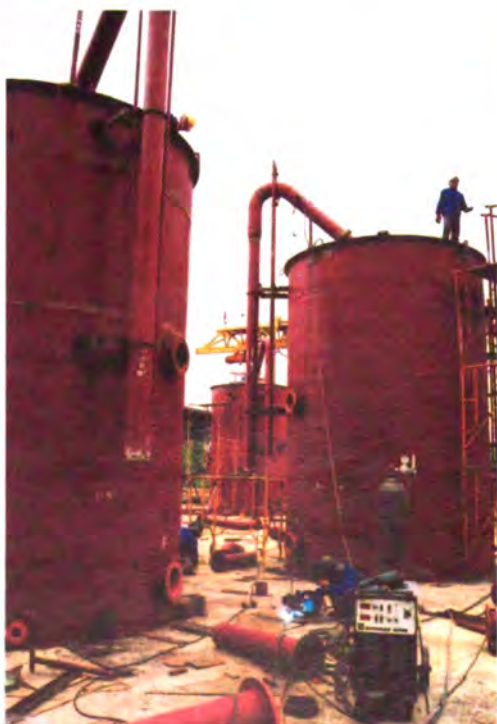
Chế tạo thiết bị ở xí nghiệp cơ khí xây lắp hóa chất
