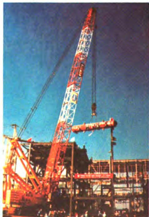
Dùng cần trục có sức nặng 500 tấn để cẩu lắp thiết bị nặng tại Công ty Nhiệt điện Phú Mỹ I
