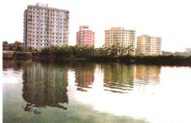
Chung cư 9-12 tầng CT5 & CT6 (275 hộ) tại khu Đô thị mới Định Công
