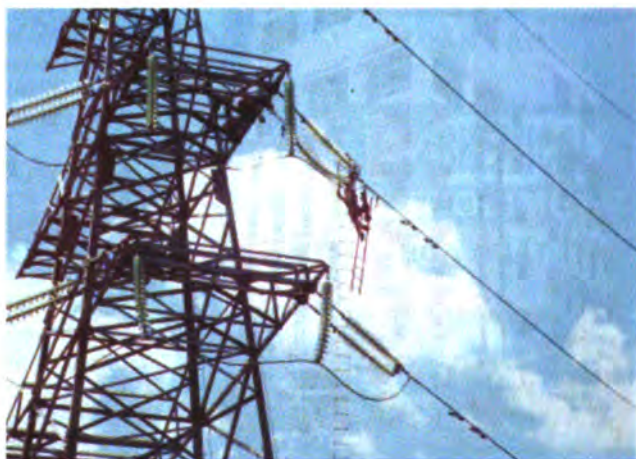
Sửa chữa đường dây 220 KV Hòa Bình - Hà Tây
