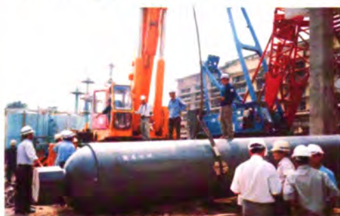
Lắp đặt thiết bị tại công ty phân đạm hóa chất Hà Bắc
