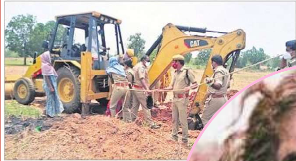
ట్రాక్ పనులు చేపట్టిన అటవీ అధికారులు
