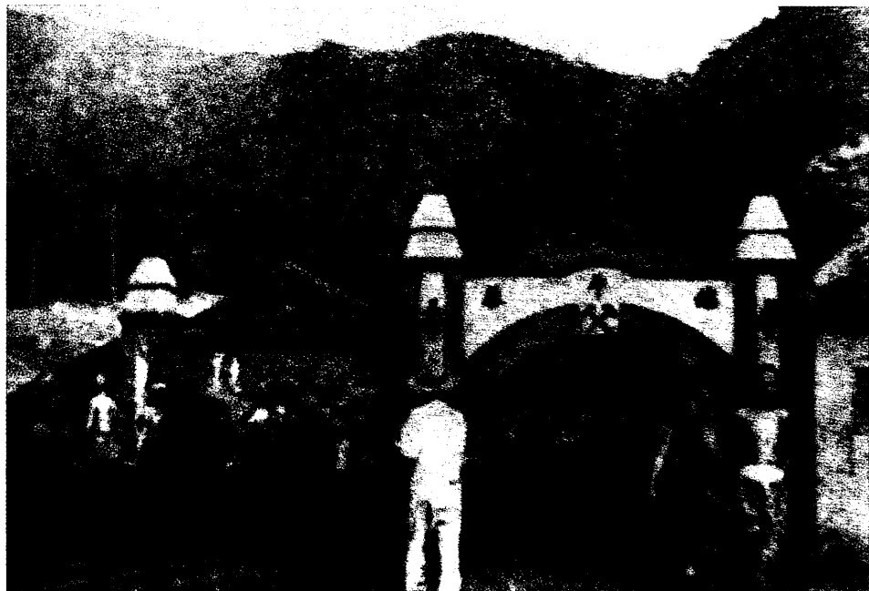
1921年秋，毛泽东到江西萍乡安源考察。图为毛泽东考察过的总巷平矿井。
